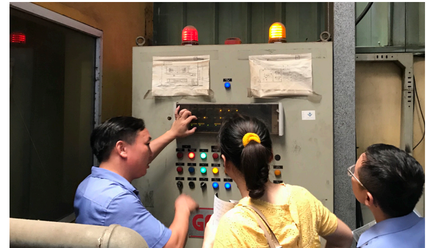
Cán bộ công ty giới thiệu về bảng điều khiển đường bơm dẫn cyclo-pentane
