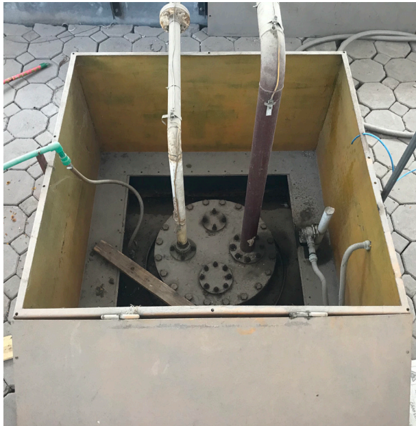
Cổng bơm và cảm biến lắp trên nắp bồn chứa cyclo-pentane (đặt ngầm dưới đất)
